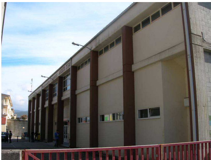
Foto 1 - Vista da fachada norte do edificio
