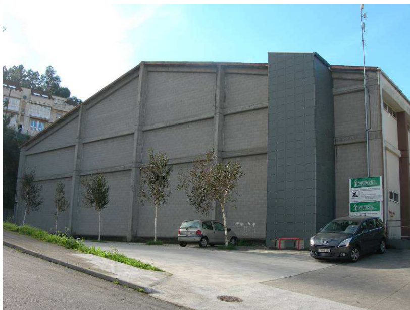
Foto 2 - Vista da fachada este do edificio
