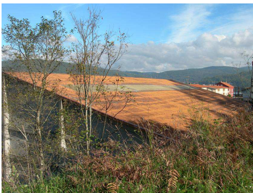
Foto 8 - Vista da cuberta do edificio (III)
