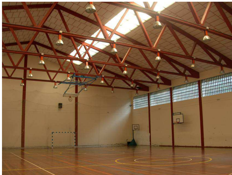
Foto 9 - Vista do interior do edificio (I)
