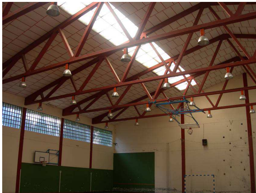
Foto 11 - Vista do interior do edificio (III)
