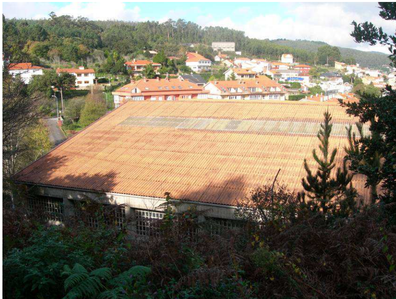
Foto 7 - Vista da cuberta do edificio (II)
